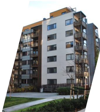
Pilestredet Park 124 ladestasjoner
