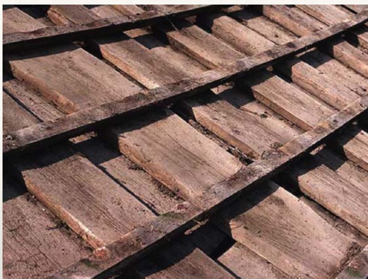
Undertak med over- og underliggere av uhøvlede bord monterert i fallretningen. Foto: SINTEF Byggforsk
