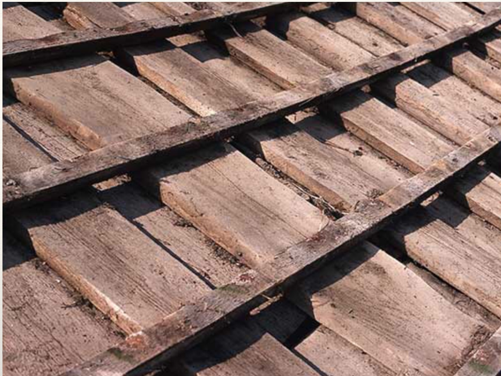
Undertak med over- og underliggere av uhøvlede bord montert i fallretningen. Foto: SINTEF Byggforsk
